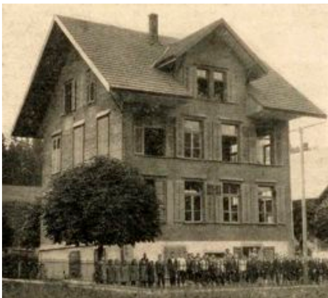
2. Schulhaus Lehn: Dieses Schulhaus im Lehn wurde 1904 bezogen.
